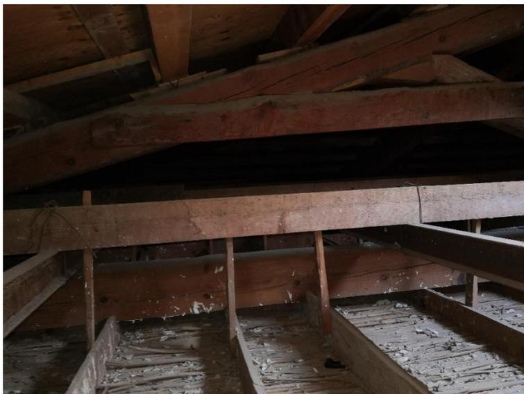
**Foto n. 17 - Copertura in legno e controsoffitto incannucciato**
