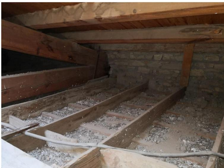
**Foto n. 18 - Assenza di cordolo in c.a. al livello della copertura**
