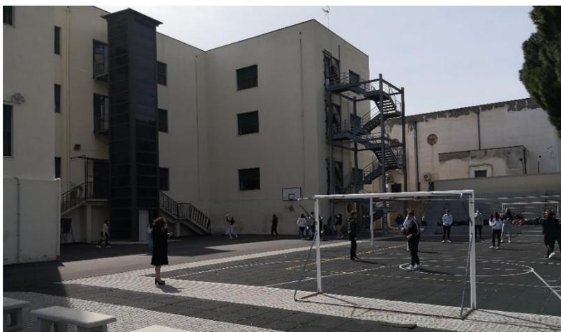
Foto n. 20 – Cabina ascensore e scala di emergenza esterna
